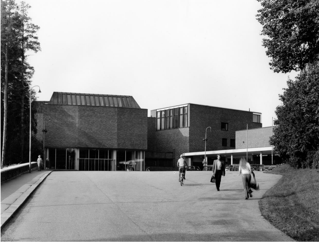
Kuva: Kari Hakli, Alvar Aalto Foundation.
