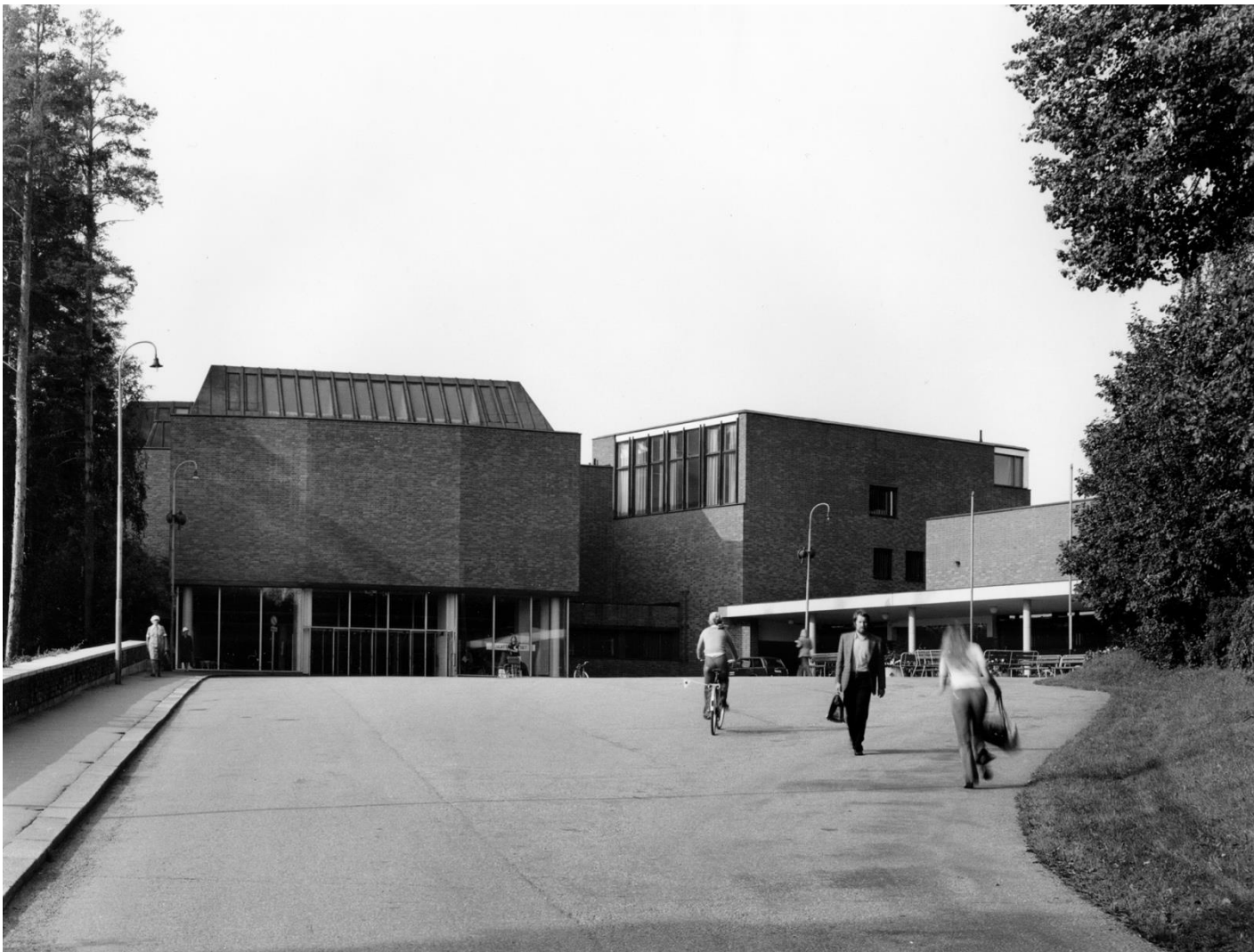
Kuva: Kari Hakli, Alvar Aalto Foundation.
