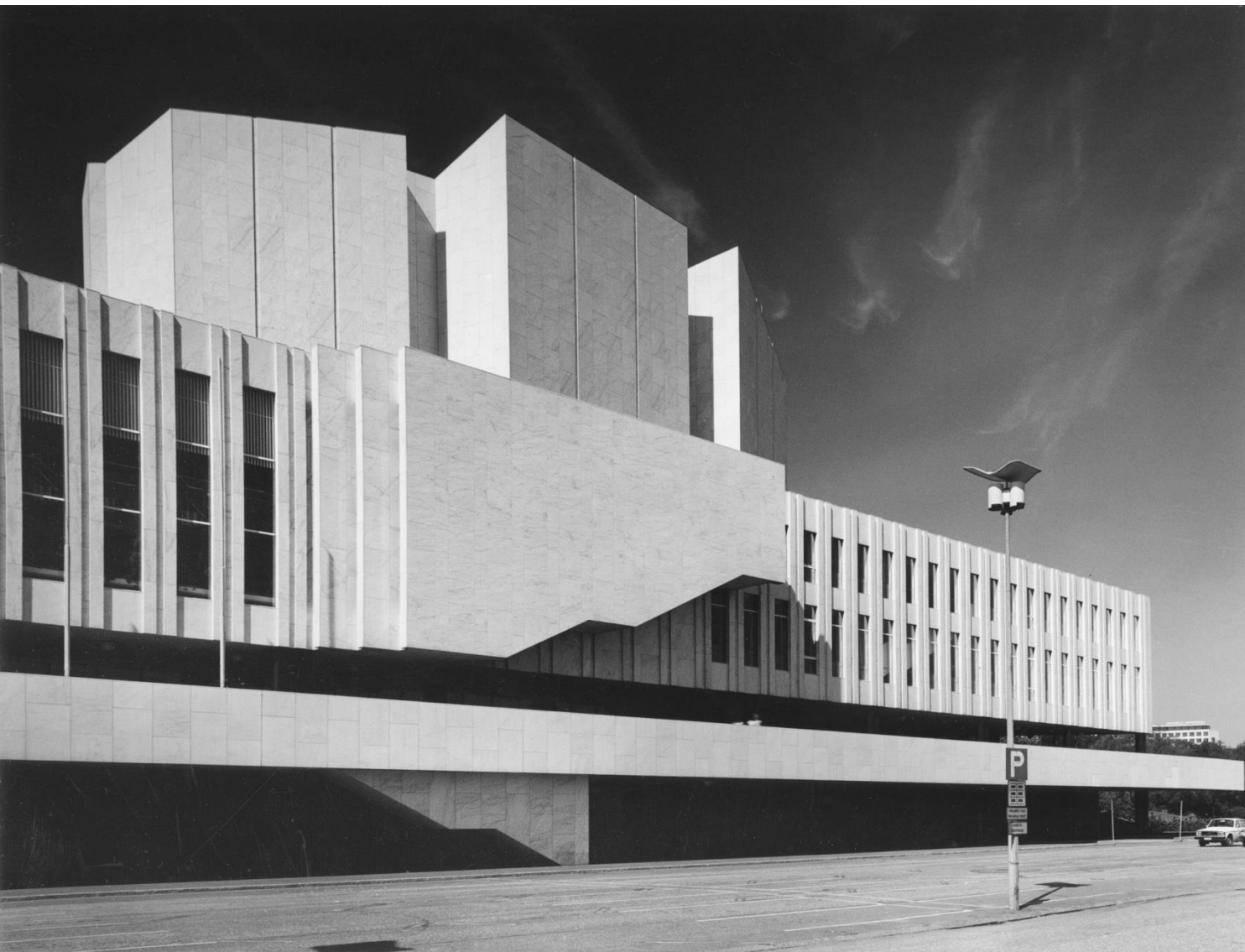
Kuva: Kari Hakli, Alvar Aalto Foundation. 1975
