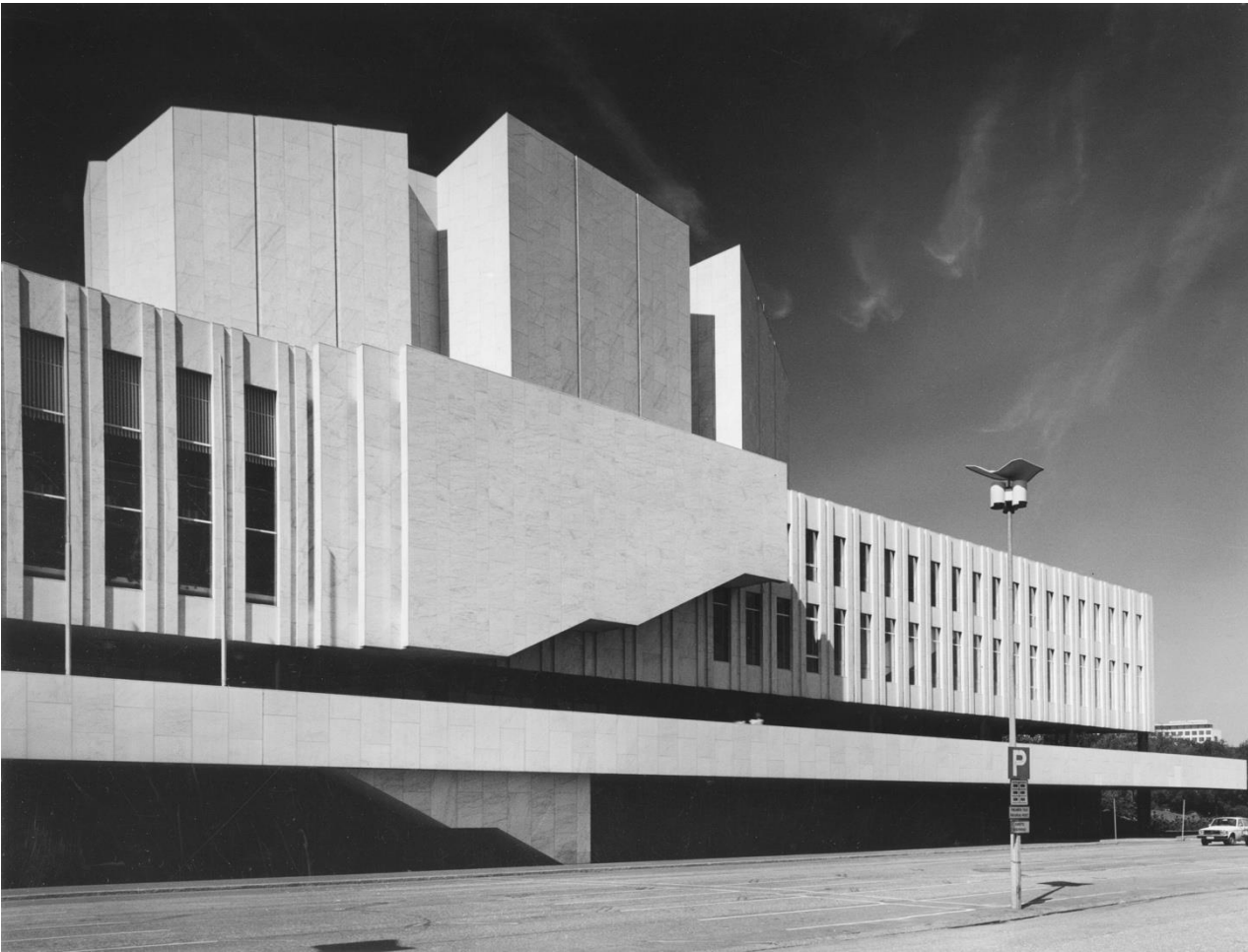
Kuva: Kari Hakli, Alvar Aalto Foundation. 1975
